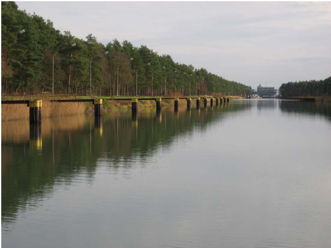
05.12.2006 – Wartestelle Niederfinow (HOW km 76,5), Blick in Richtung Osten
